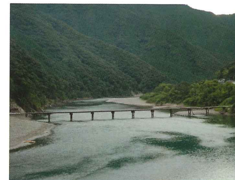
写真-37 岩間沈下橋（出典：11）
