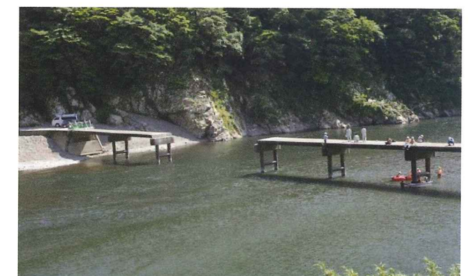
写真-40 岩間沈下橋（出典：8）
