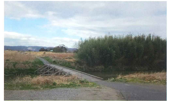
写真-2 八幡橋 (H30 (2018))
