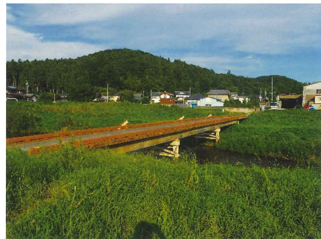
写真-43 里川の流れ橋「田渡橋」(H30 (2018))
