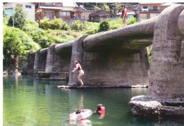
写真-33 口屋内沈下橋（出典：8）
