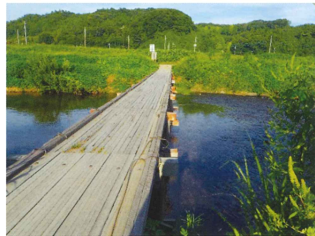
写真-41 里川の流れ橋「西宮橋」(H30 (2018))
