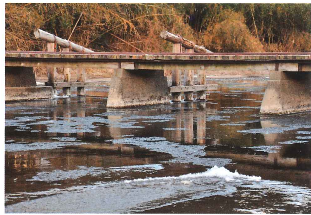
写真-28 久野瀬橋 (H22 (2010))
