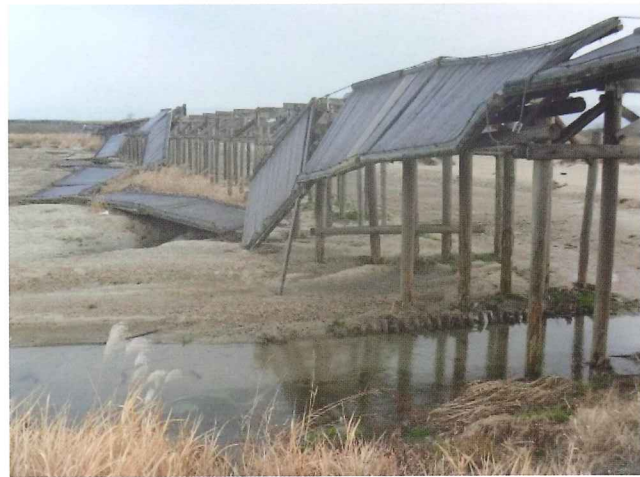
写真-49 上津屋橋（洪水後（出典：13））
