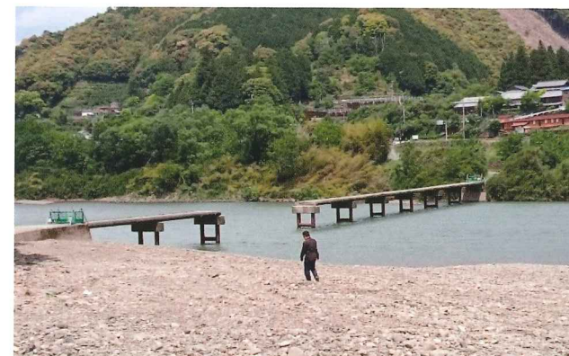
写真-39 岩間沈下橋（出典：10）
