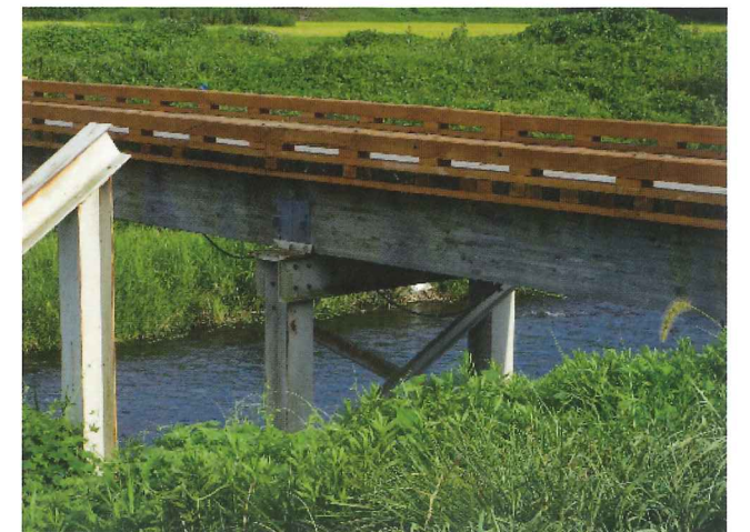
写真-46 白羽橋の桁下のロープ (H30 (2018))
