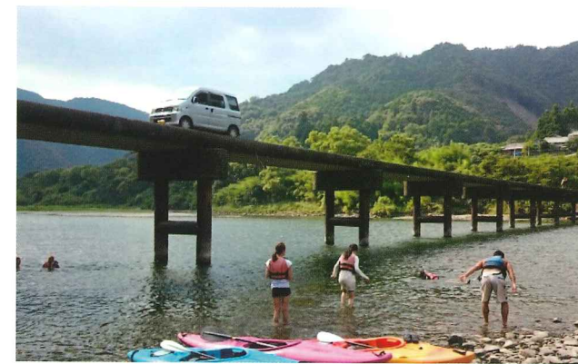
写真-35 岩間沈下橋（出典：10）
