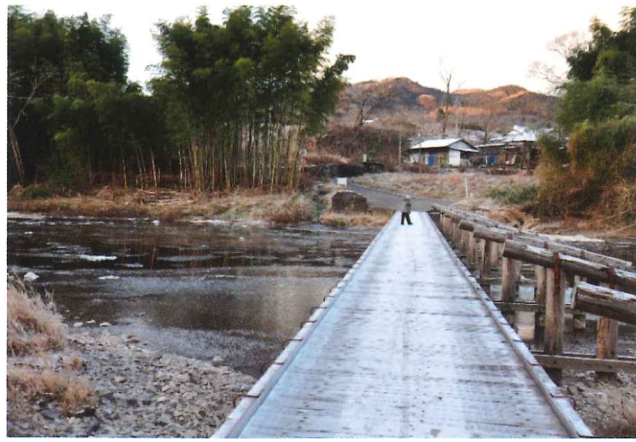
写真-27 久野瀬橋 (H22 (2010))
