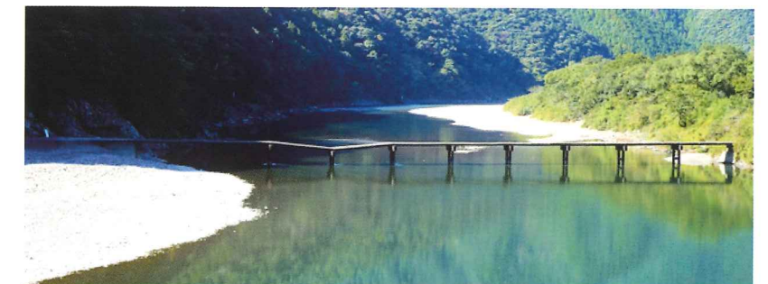
写真-38 岩間沈下橋（出典：12）
