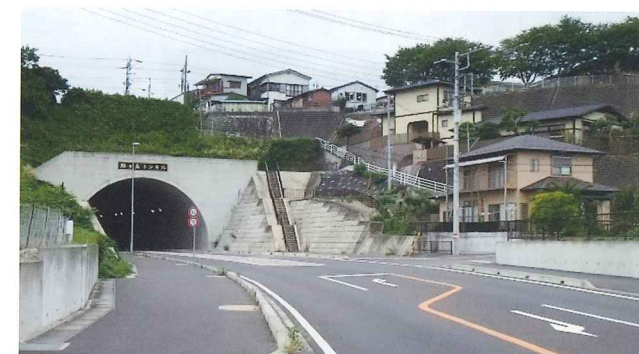
写真-21 めひこ坂の全景（トンネル右側の白い柵内）
