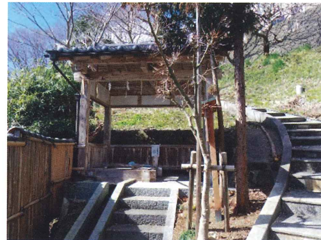
写真-31 金が井の全景
