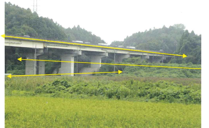
写真-18 道路の立体3層構造 2015 (H27).08 上層から 常磐高速道路、茨城線廃線跡道路、高速側道 (各々の道路下を潜る)
