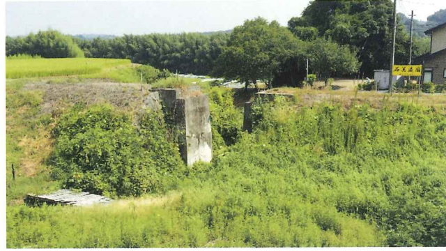
写真-45 御前山駅手前の橋台跡 2015 (H27).08
