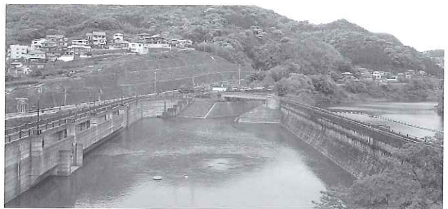
写真-7 西山ダム（長崎県）左：新ダム、右：旧ダム
