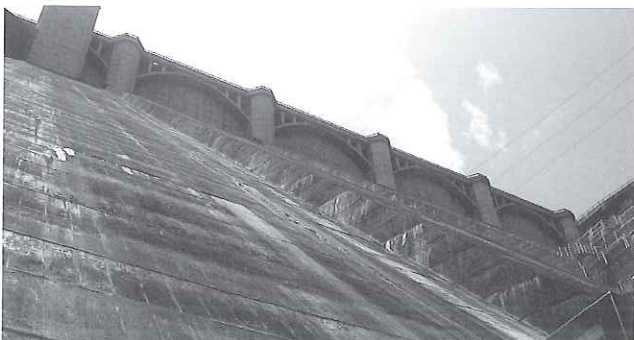
写真-4 浦山ダム（埼玉県）
